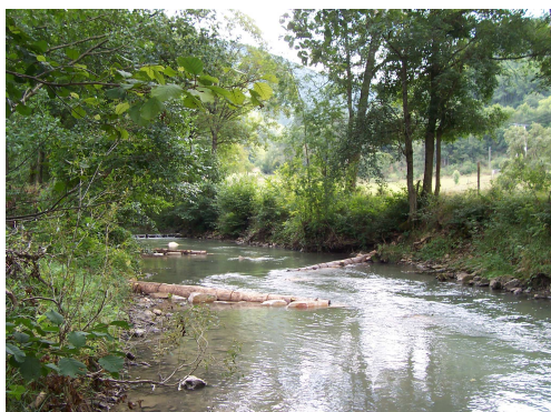
Photo 8 Aménagements réalisés sur le Bramont aux Fonts
