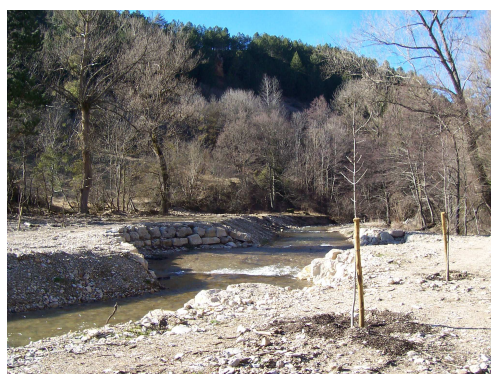
Photo 2 Aménagements sur le Bramont à Lentondre
